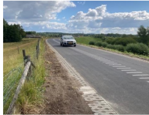
Fig. 5: Proefvak 2 met geribbelde rijloper
