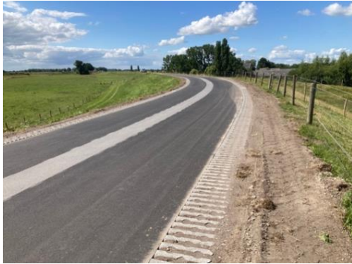
Fig. 4: Proefvak 1 met doorlopende rijloper
